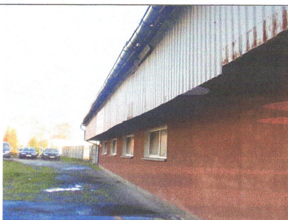
ściana frontowa budynku po kotłowni
