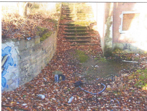
pierwotne zejście do budynku od strony zaplecza działki
